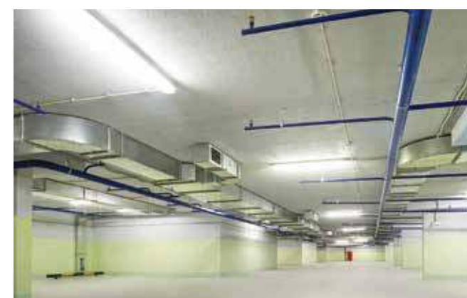
Подземная двухуровневая автостоянка, г. Королев
